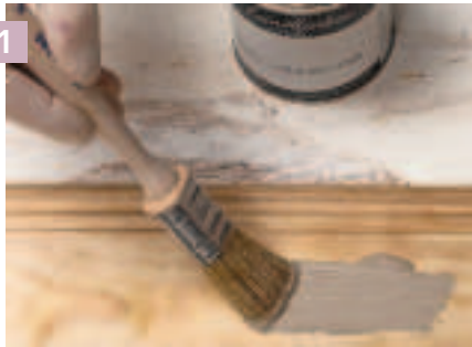
1 24 Stunden nach der Grundierung des rohen Holzes mit kaltgepresstem Leinöl kann der erste Farbanstrich erfolgen. Mit einem Naturhaar-Pinsel wird die Farbe dünn aufgetragen.
