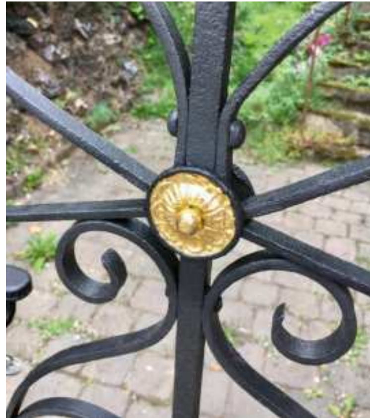
Abb. 5 Zaundetail, fertiges Resultat mit Vergoldung
