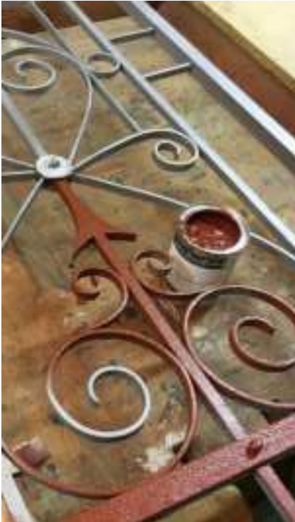
Abb. 3 Zaundetail, sand- gestrahlt und erster Anstrich mit Hämatit
