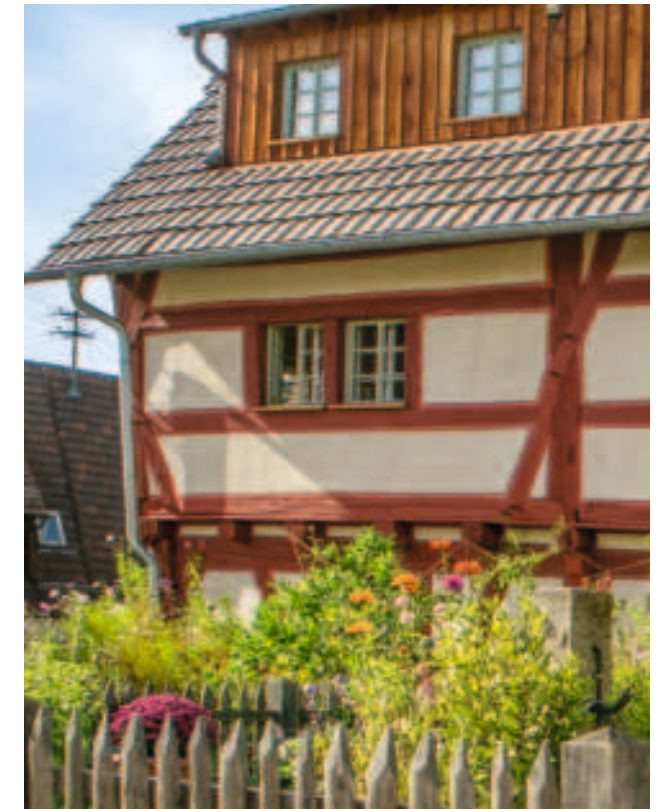
An dem 500 Jahre alten Baudenkmal in Bodelshausen bei Tübingen sind Fachwerk und Fenster, wie früher, mit Leinölfarbe gestrichen.
