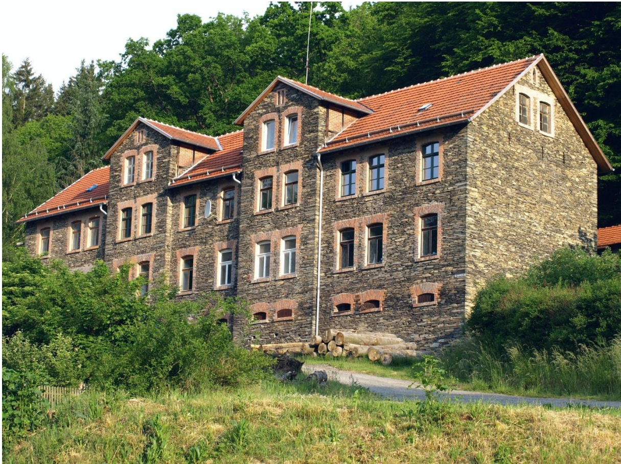
Abbildung 1: Ansicht des Hauses von Südosten, Schieferbruchstein mit Lehmörtel und Ziegellaibungen
